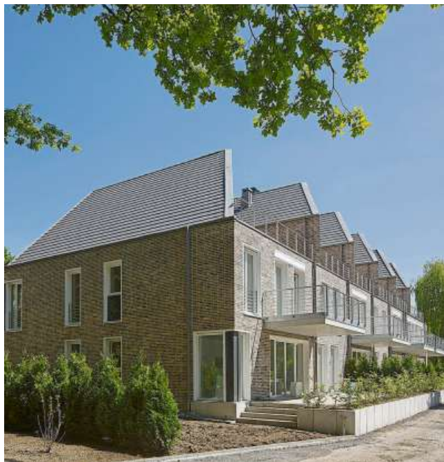
In direkter Nachbarschaft an der Mondstraße hat die Firma Hubert Nabbe außerdem ein Reihenhaus mit elf Eigentumswohnungen gebaut. Fotos: Hubert Nabbe GmbH
