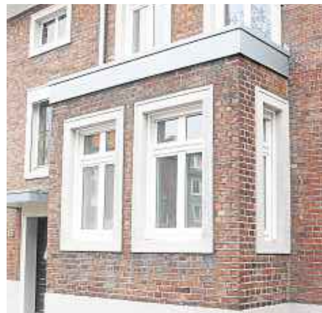
Mit viel Liebe zum Detail hat die Nabbe GmbH der Altbauvilla mit dem Erker neuen Glanz eingehaucht.
